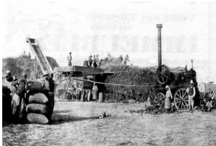
FLATTERS en 1931: les battages par l'entreprise LARFEUIL
